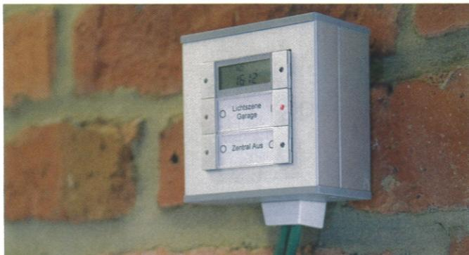
Passend zum rustikalen Flair wurde die Erweiterungsinstallation Gira Profil 55 eingesetzt und die Kabel aufputz verlegt
