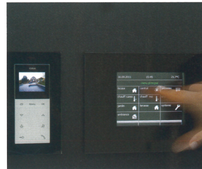
Die gesamte Haustechnik lässt sich zentral über das Gira InfoTerminal Touch in der Küche kontrollieren, visualisieren und steuern. Hierfür ließ der Bauherr in optischer Anlehnung zum Schalterdesign Gira Esprit Glas schwarz eigens einen passenden Rahmen anfertigen
