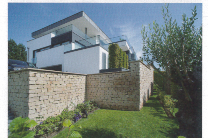
Die Besonderheit des Baugrundes zeigt sich im markanten Höhenunterschied von jeweils 5 m entlang der Grundstückslänge und -tiefe.
